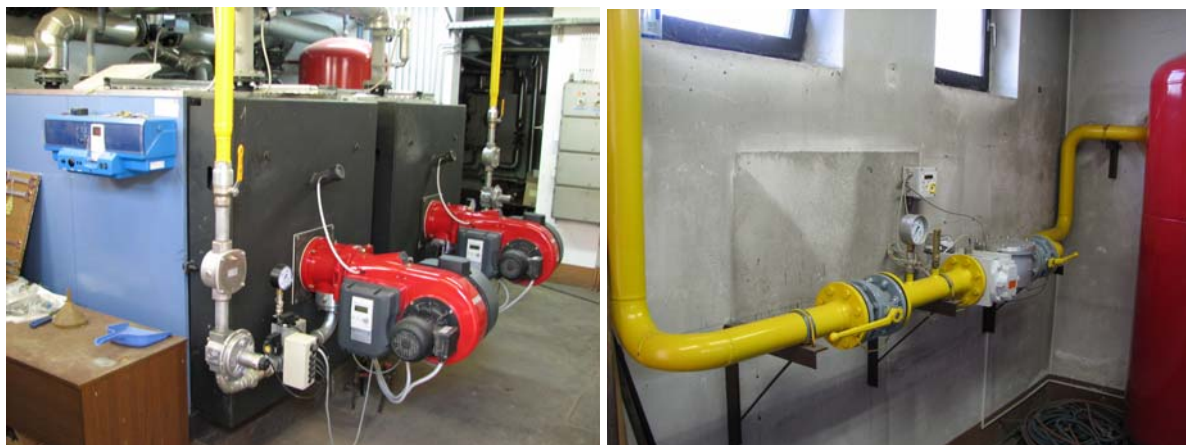
Slika 8: Plinska kotla in merilnik ZP v kotlovnici na Zelenici 3c
