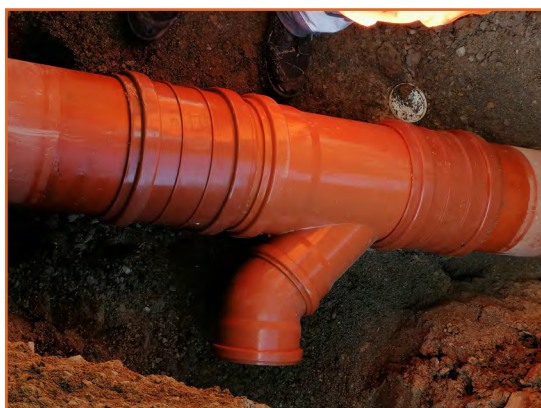
Izvedba priključka na javni vod
