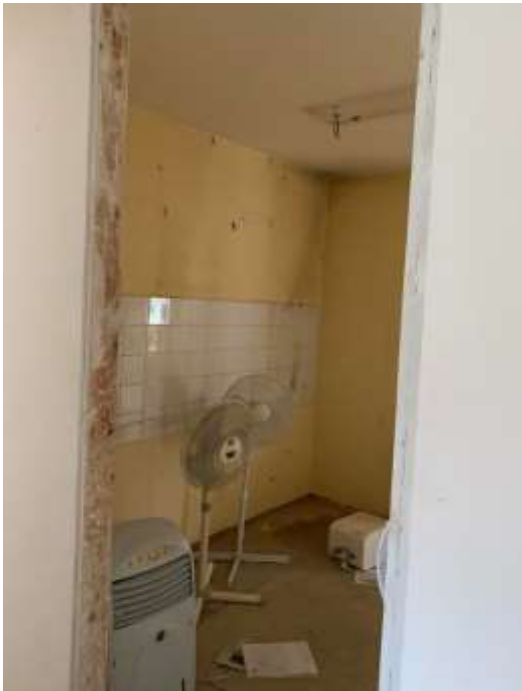
Slika 4: Prikaz stanja objekta – notranjost 2
