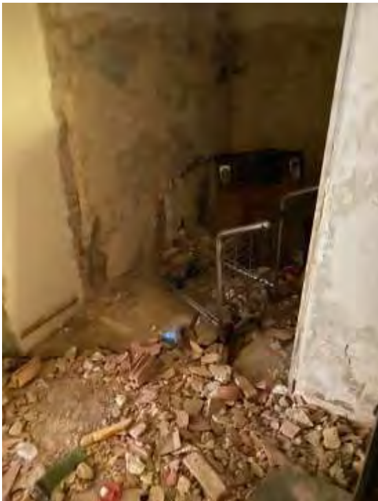
Slika 3: Prikaz stanja objekta – notranjost 1
