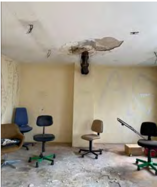
Slika 5: Prikaz stanja objekta – notranjost 3
