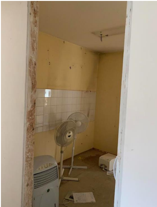
Slika 4: Prikaz stanja objekta – notranjost 2
