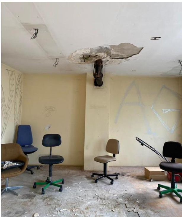
Slika 5: Prikaz stanja objekta – notranjost 3
