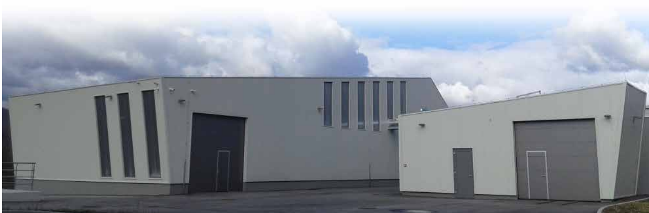
Čistilna naprava Borovnica
