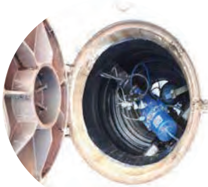
Jašek na podtladni kanalizaciji
