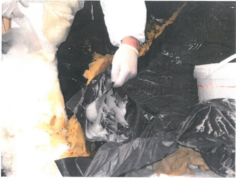
Sliki 9 in 10: Nanašanje smole na zaščitno plast folije po obliki deblaka.
