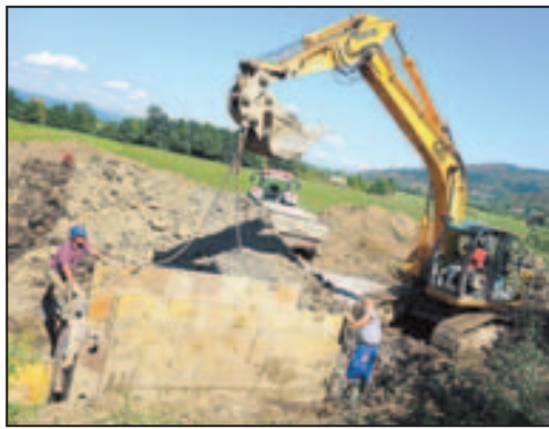
Izkopi na barju zahtevajo posebno tehniko.
