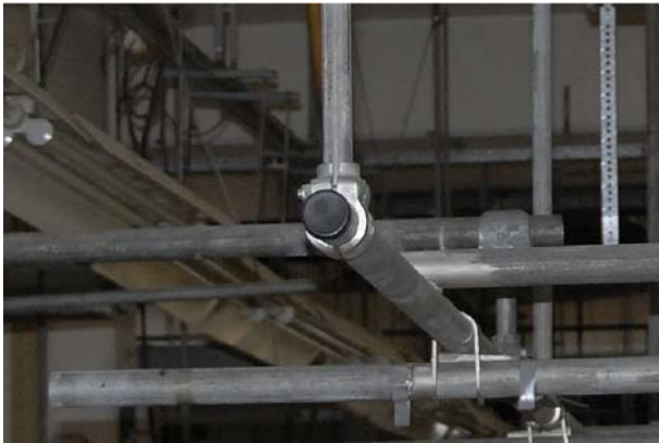
obešanje cevi \phi 42 na \phi 26
