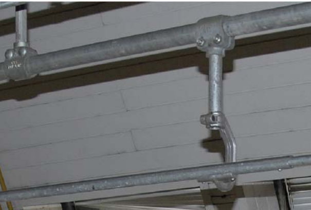
Do5 kljuka nosilec trase vozička komplet z obešalno palico in objemko
