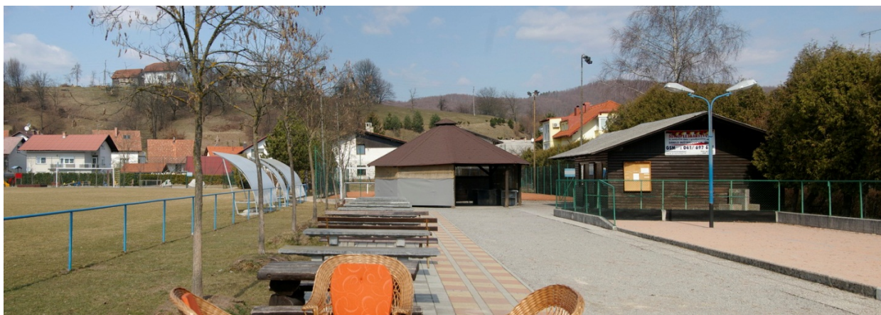
POGLED NA OBSTOJEČE DOTRAJANE MONTAŽNE OBJEKTE
