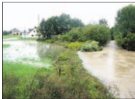
Leta 2010 je pod regionalno cesto nastal čep, ki je zadrževal odtekanje poplavnih voda.
