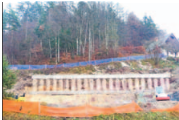
Danes je na parceli, kjer naj bi že naslednje leto stal poslovni objekt, viden izkop in zgrajena zaščitna stena.
