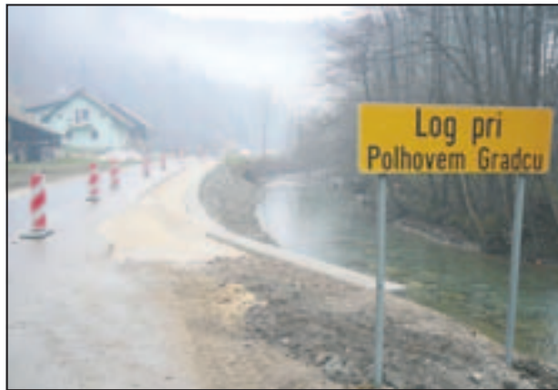
Urejanje struge Gradaščice na poplavno najnevarnejšem območju na Logu so poglobili in utrdili strugo, ta dela pa so kar nekaj časa motila promet tod mimo.
