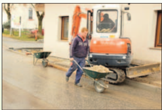
Gradnja pločnika na Slovenski cesti
